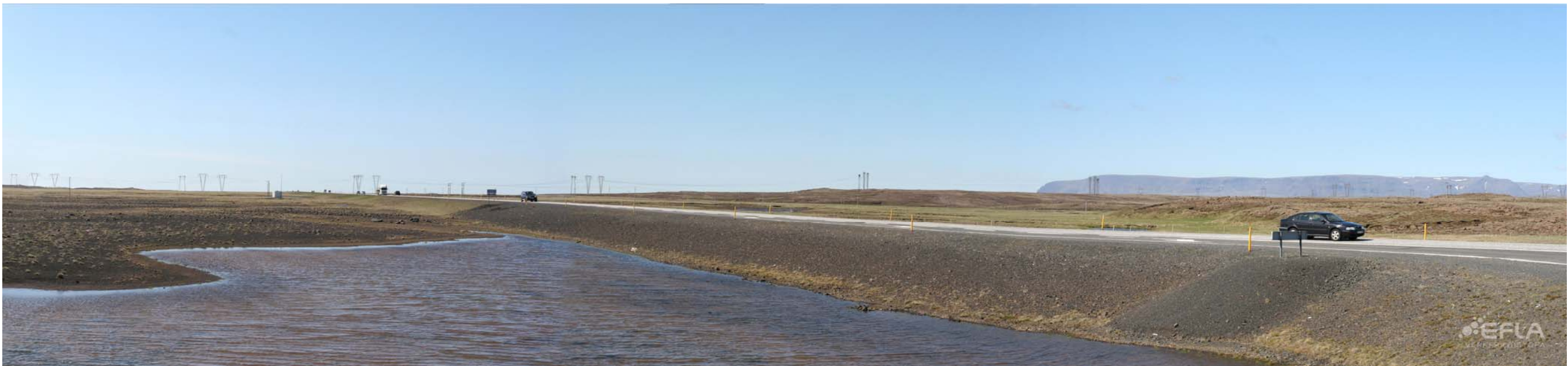
Mynd 24: Bláfjallavegur, þverun við Sandskeið. Að lokinni framkvæmd.
