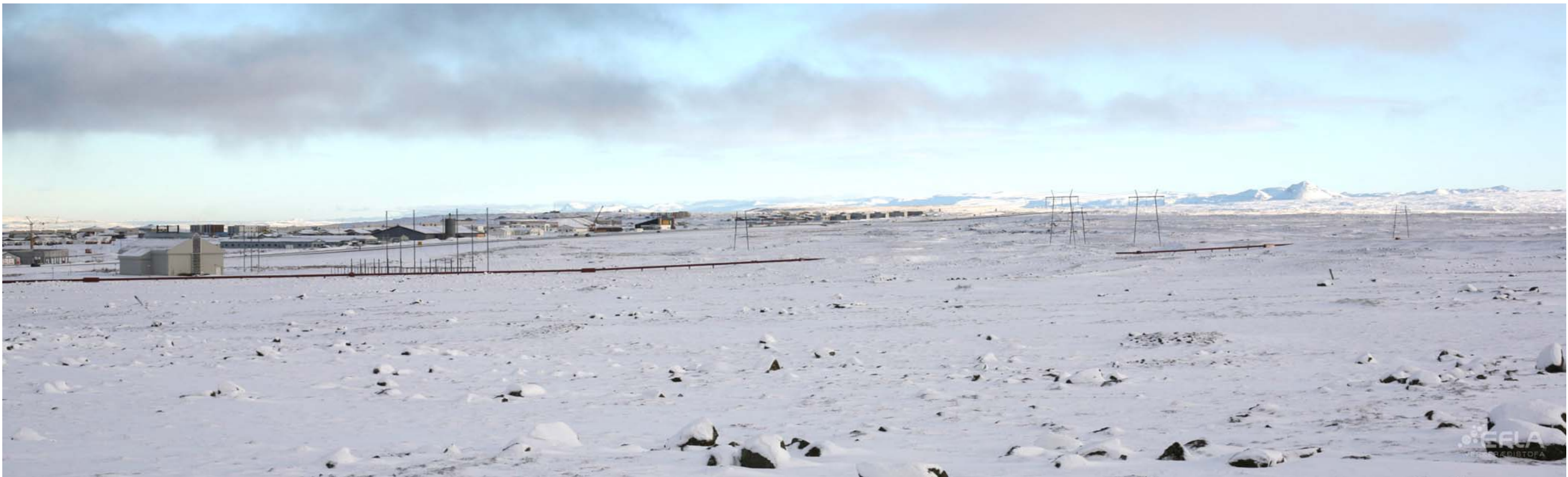
Mynd 76: Reykjanesbær, að tengivirki við Fitjar og Reykjanesbraut. Að lokinni framkvæmd.
