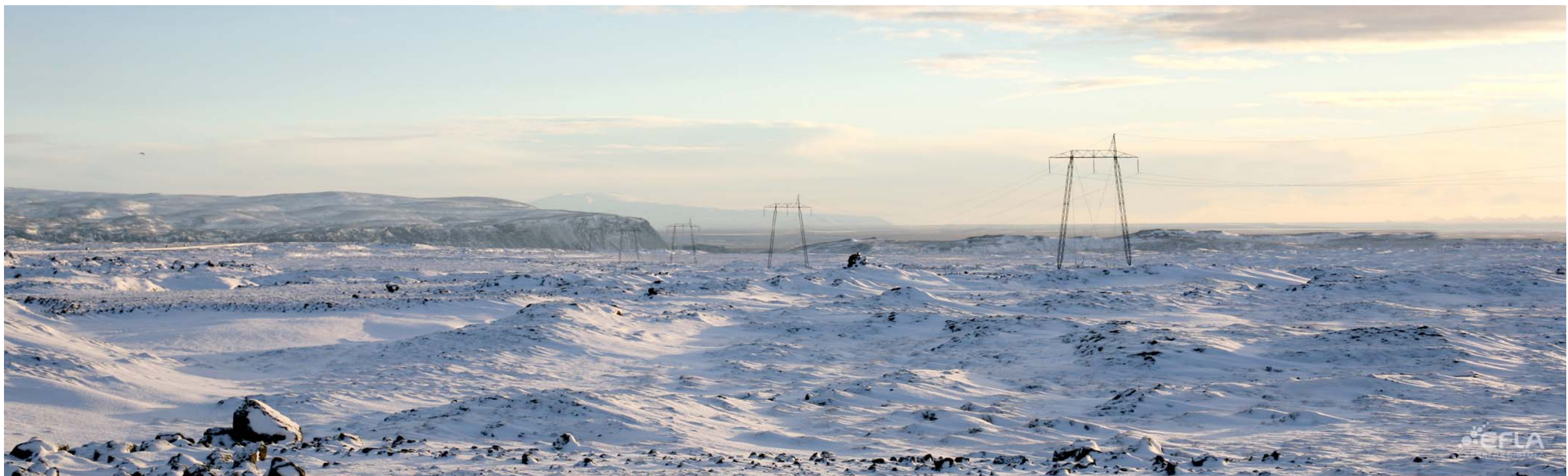
Mynd 6: Hellisheiði. Þjóðvegur 1 að Hveragerði. Að lokinni framkvæmd.
