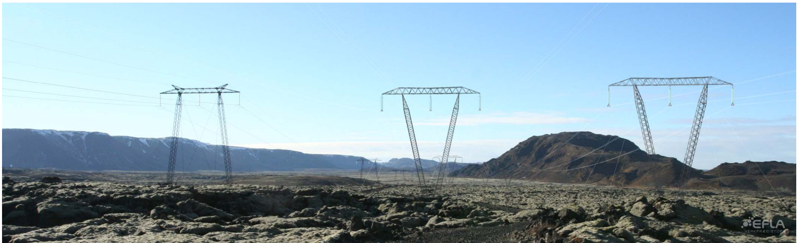
Mynd 34: Húsfellsbruni að Helgafelli. Að lokinni framkvæmd.
