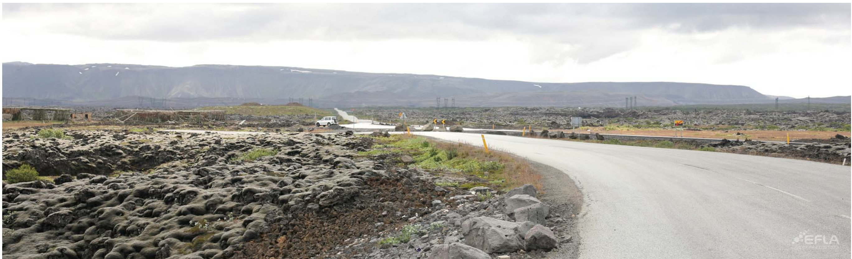
Mynd 50: Krýsuvíkurvegur að Undirhlíðum. Valkostur A að lokinni framkvæmd.
