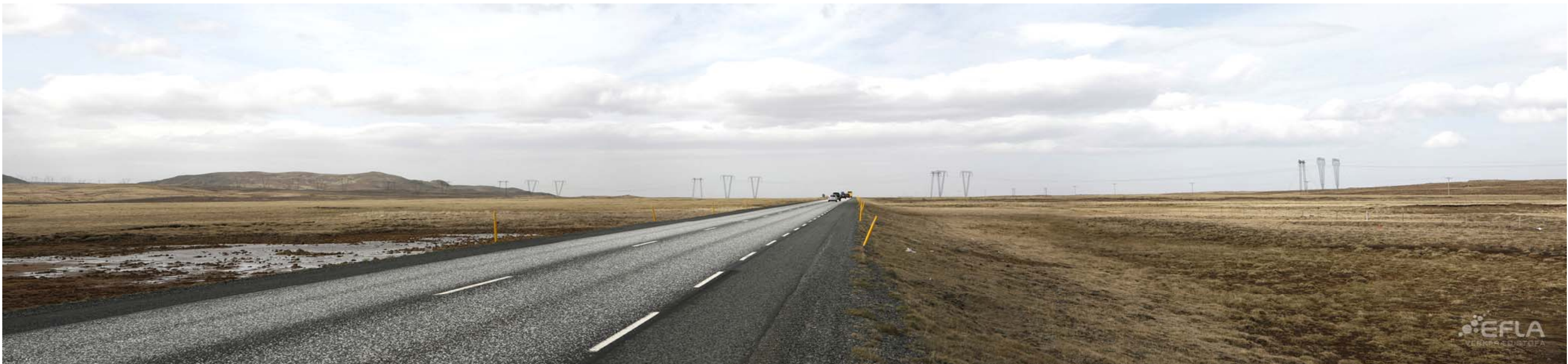
Mynd 26: Þjóðvegur 1, þverun við Sandskeið. Að lokinni framkvæmd.
