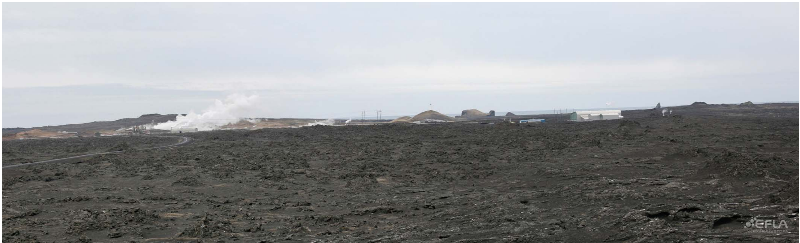
Mynd 82: Frá Stampagígum að Reykjanesvirkjun. Að lokinni framkvæmd.
