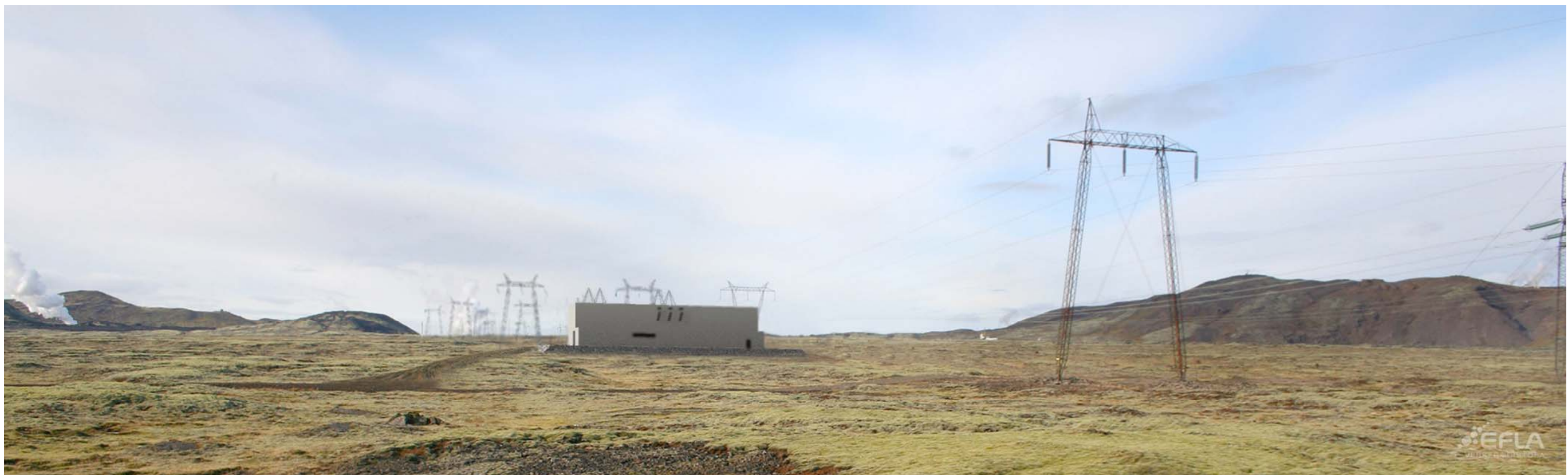
Mynd 4: Hellisheiði. Þjóðvegur 1 að Skarðsmýrarfjalli og Hellisskarði. Að lokinni framkvæmd.
