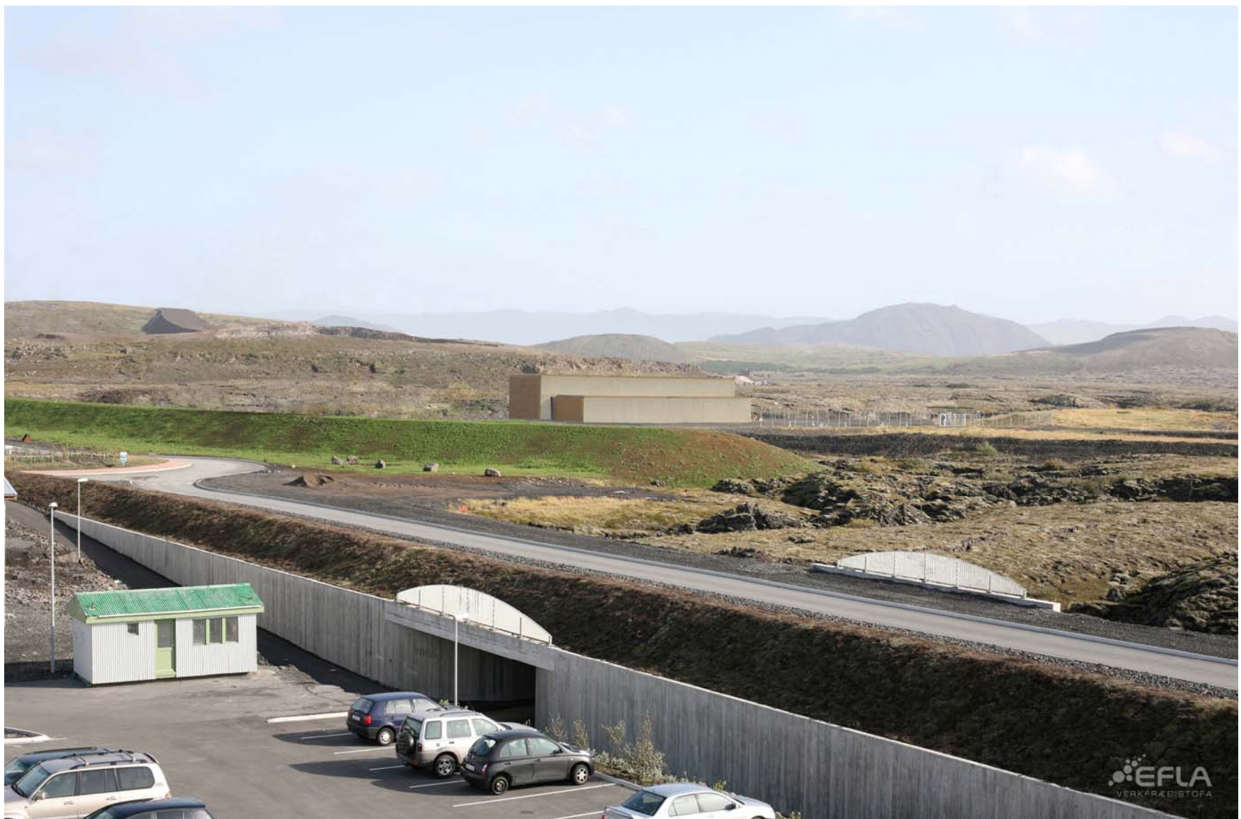
Mynd 64: Byggð í Hafnarfirði að tengivirki við Hamranes. Eskivellir, að lokinni framkvæmd.
