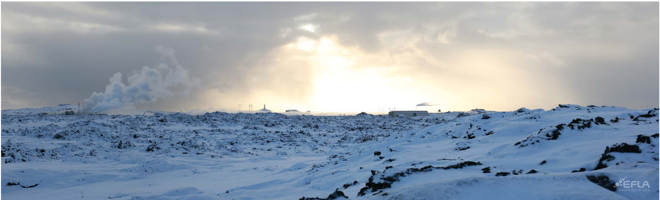
Mynd 86: Frá Stampagígum að Reykjanesvirkjun. Að lokinni framkvæmd.
