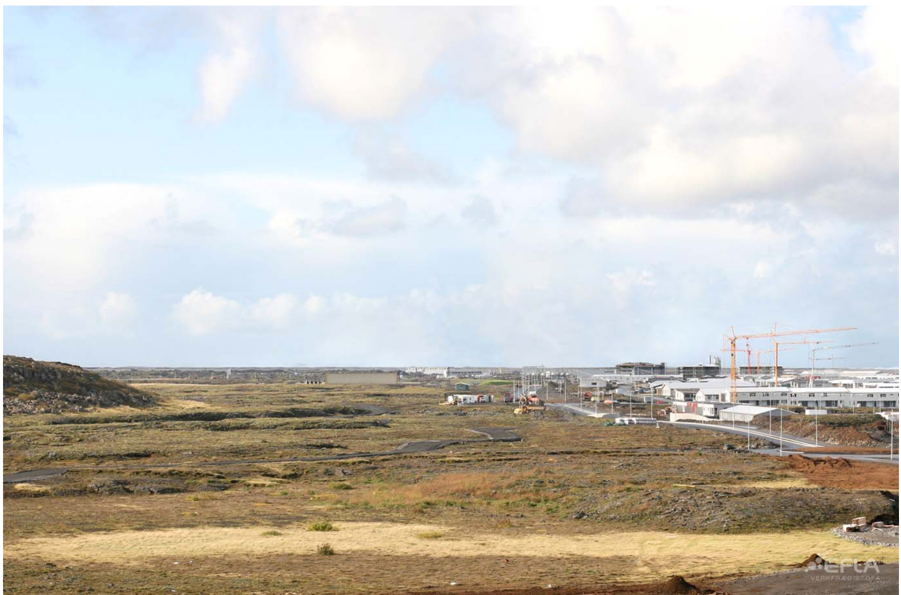
Mynd 68: Byggð í Hafnarfirði að tengivirki við Hamranes. Ásfjall, að lokinni framkvæmd.
