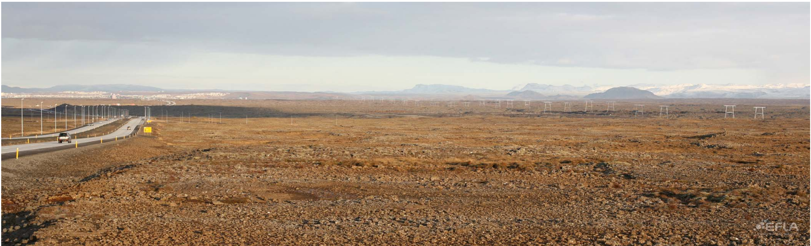
Mynd 72: Reykjanesbraut að Kúagerði. Að lokinni framkvæmd.
